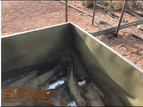
SE corner edge degradation
