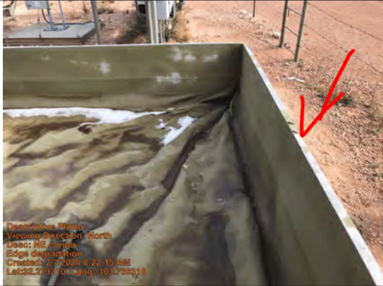
NE corner. Edge degradation.
