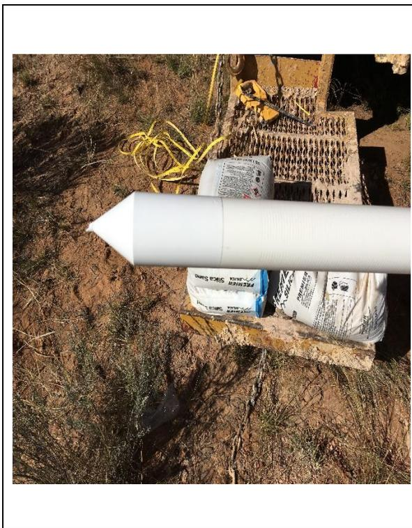
Photo 52—Well casing bottom plug.
