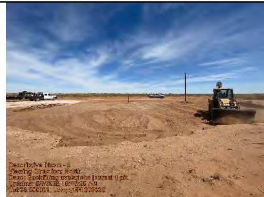
Backfilling avalanche journal 1 pit.
