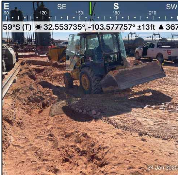
Photo 13. Backfilling the excavation in the general sub-areas of CS-03, CS-04, CS-05, and CS-06.
