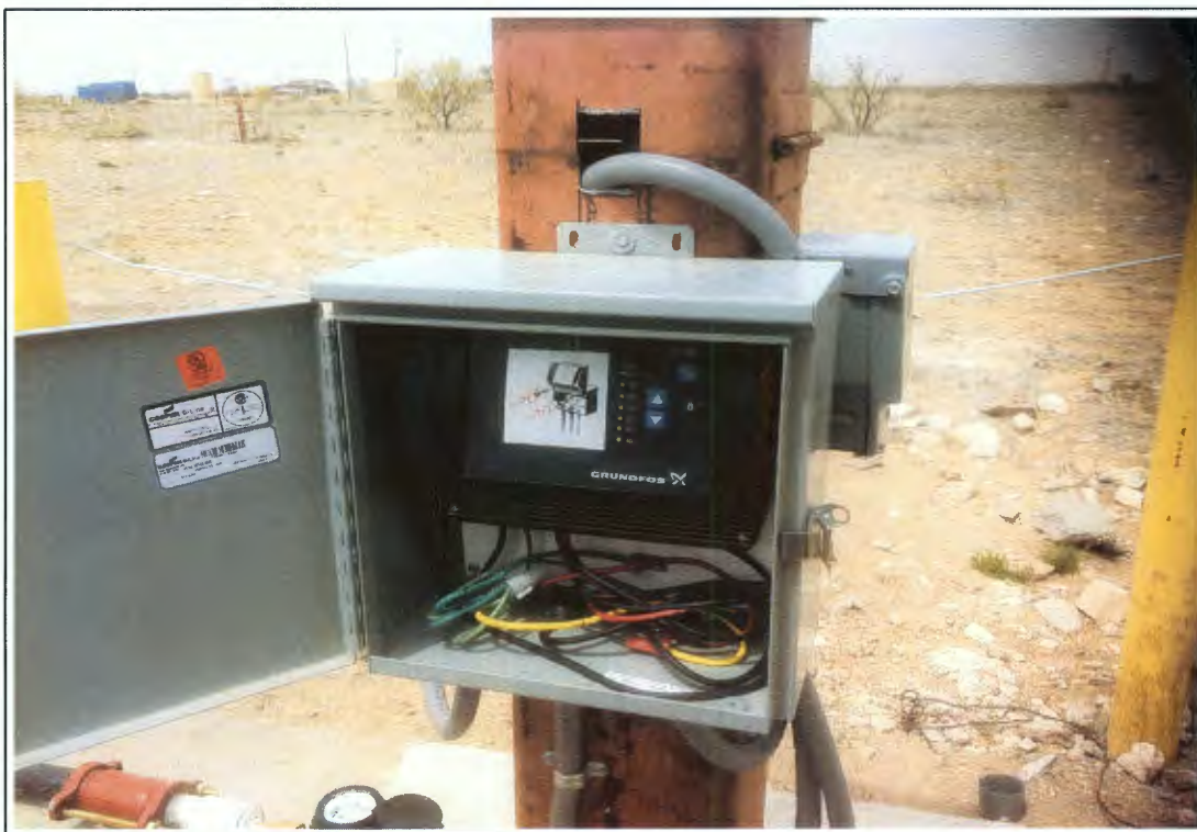
6. Grundfos CU 301 pump controller
