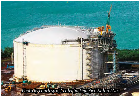
1.4: Cryogenic tank storing LNG at -162^{\circ}\text{C} .
