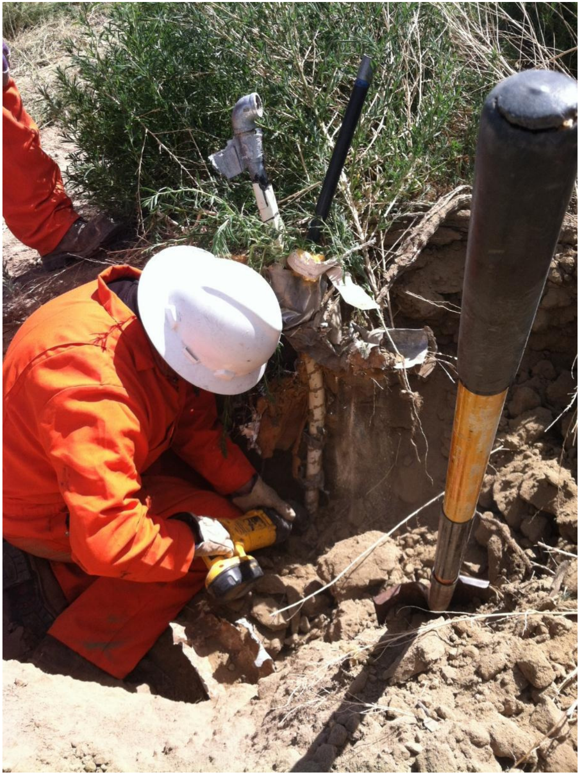
Electrical conduit removal.
