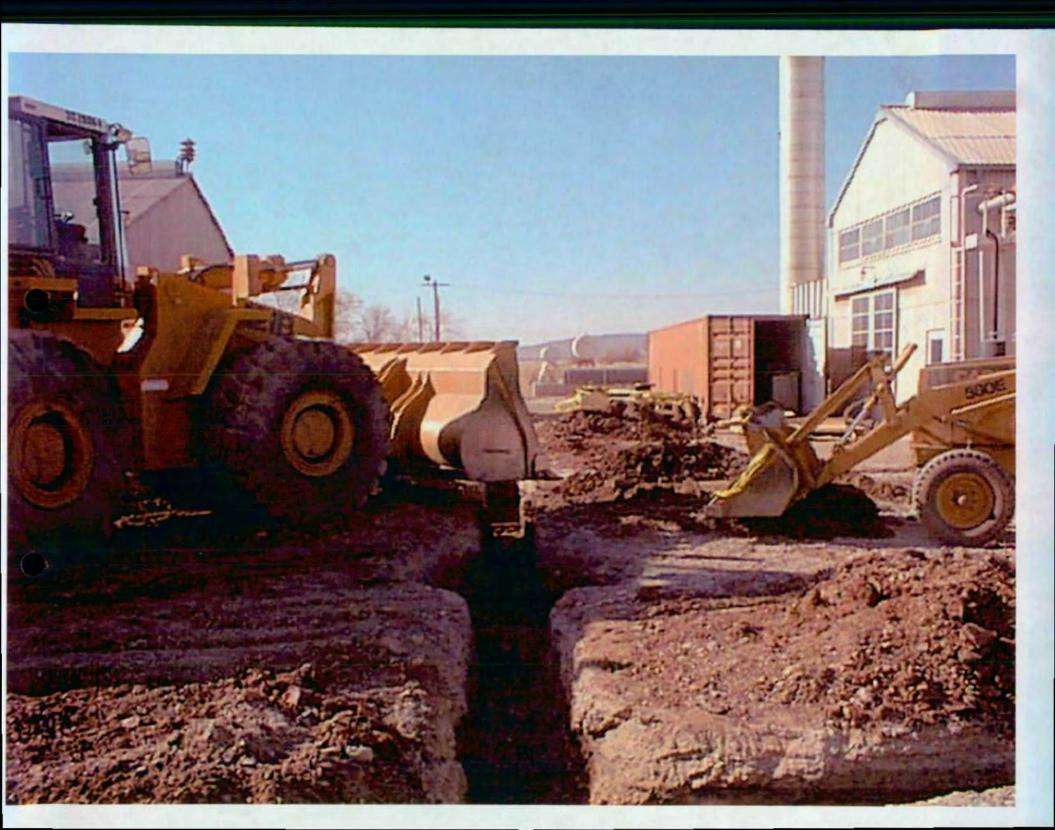
NEW DRAIN LINE DITCH RUNNING EAST & WEST. SOUTH OF BOILER HOUSE TO EXISTING SUMP S.W. CORVER OF BUILTA HOUSE.
