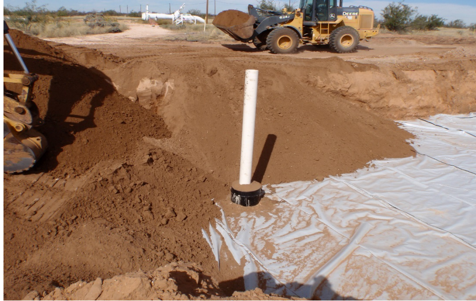
PVC Conduit Installation
