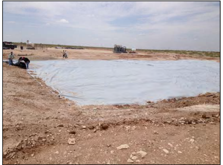
Installing geomembrane cover 7/2/2014
